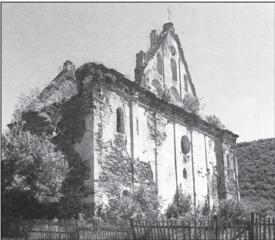
Bažnyčios griuvėsiai greta Chervonhorodo pilies.
