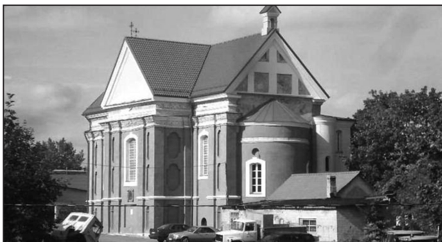
Restauruojama Šv. Stepono bažnyčia.
