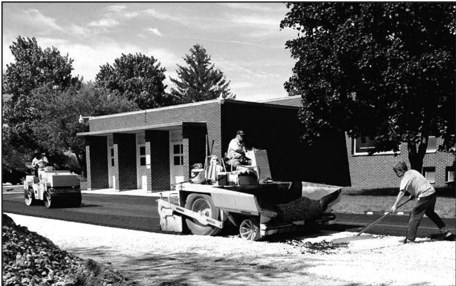
Vienas iš daugelio Centro atnaujinimo darbų – asfaltuojama vakarinė automobilių stovėjimo aikštelė.
