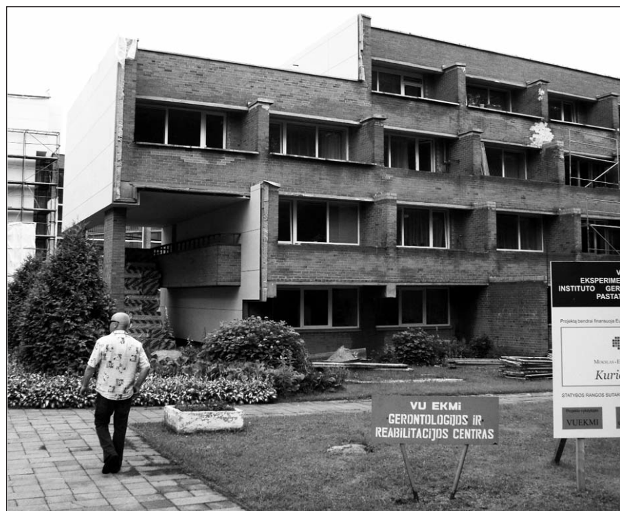
Gerontologijos ir reabilitacijos centre – remonto darbai.
