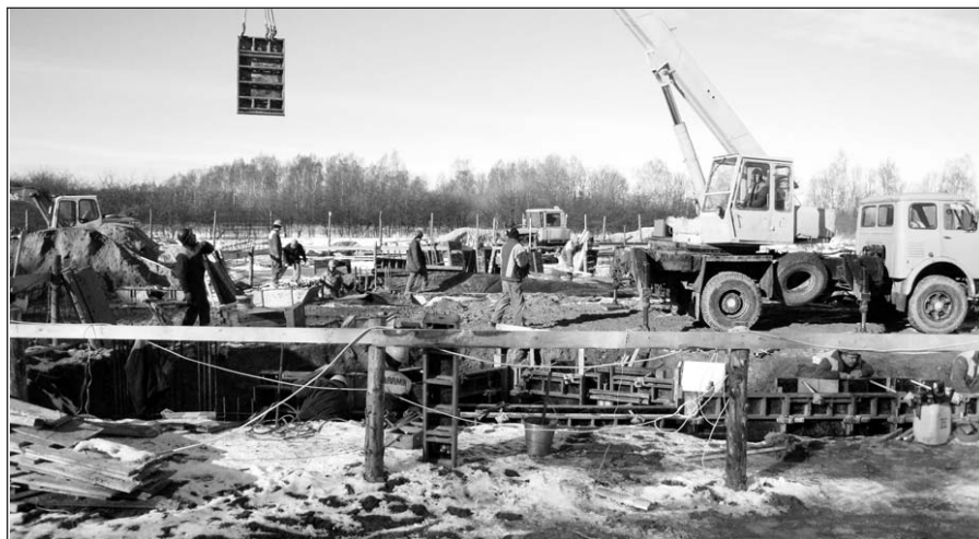
Jau padėti koplyčios pamatai.
