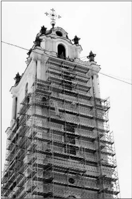
Į Šv. Jonų bažnyčios varpinę kels liftas. Valdo Kopūsto (ELTA) nuotr.
