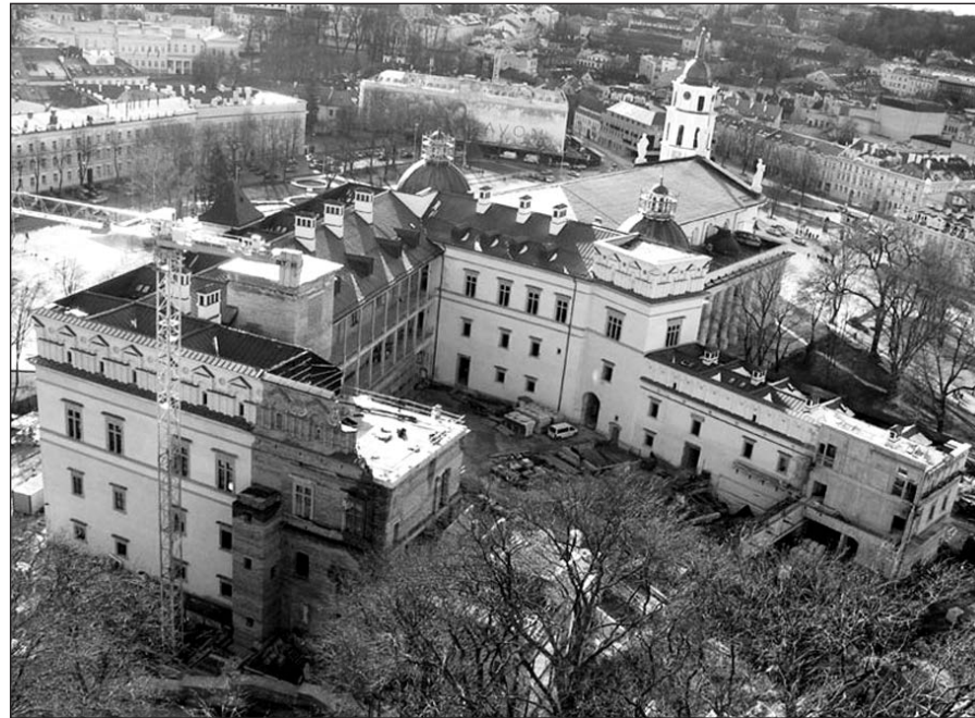
Valdovų rūmų statybos iš Vilniaus aukštutinės pilies bokšto 2008 m. kovo mėn.
