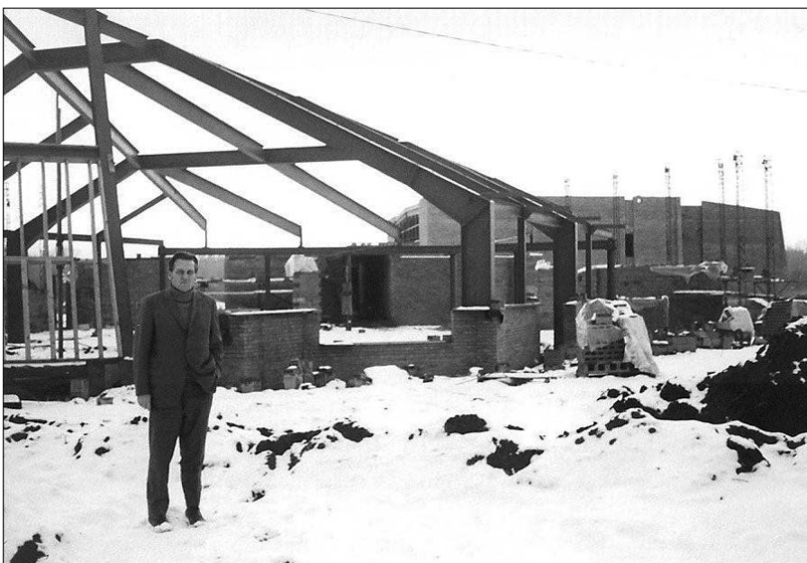
Architektas Albertas Kerelis prie vykstančios statybos.
