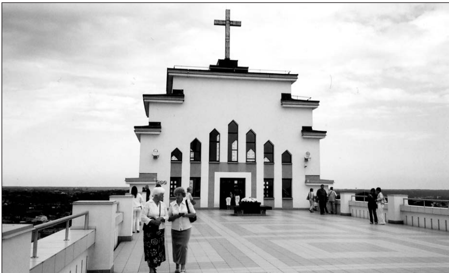
Prisikėlimo bažnyčios stogas Žaliakalnyje Kaune.
